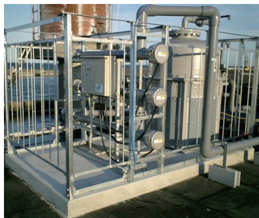
魚市場の魚洗浄水消毒装置 (ろ過+紫外線)
