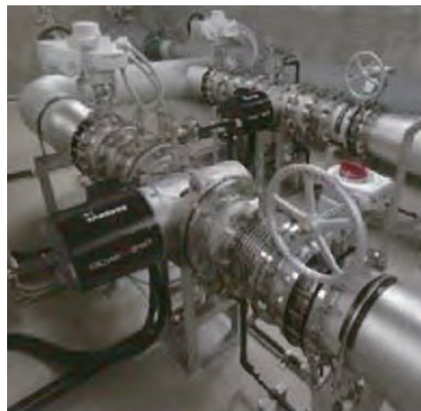
浄水用紫外線照射装置 (対象水:急速ろ過された伏流水)
