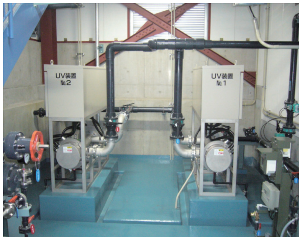
浄水膜ろ過配水用紫外線照射装置 (内部照射型横置き)
