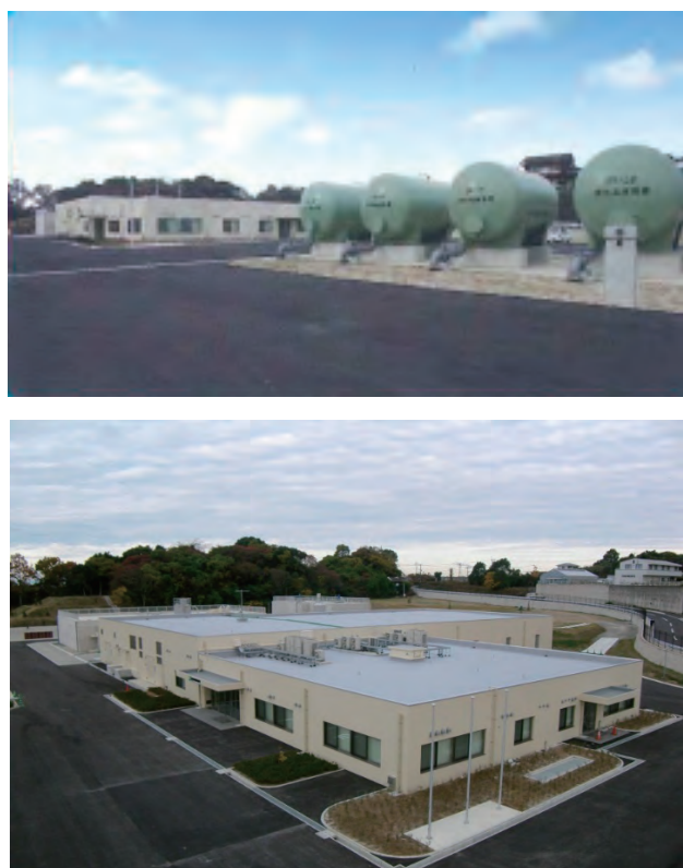
図3、4 ありあけ浄水場
