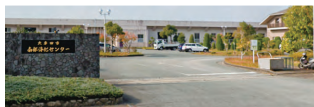
図7 大牟田市南部浄化センター
