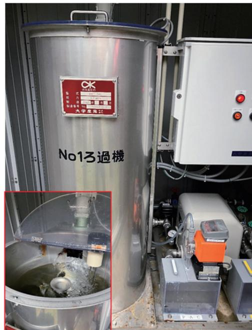
図2 ユニット型ろ過装置
