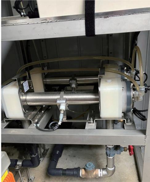
図3 UV-LED水処理装置
