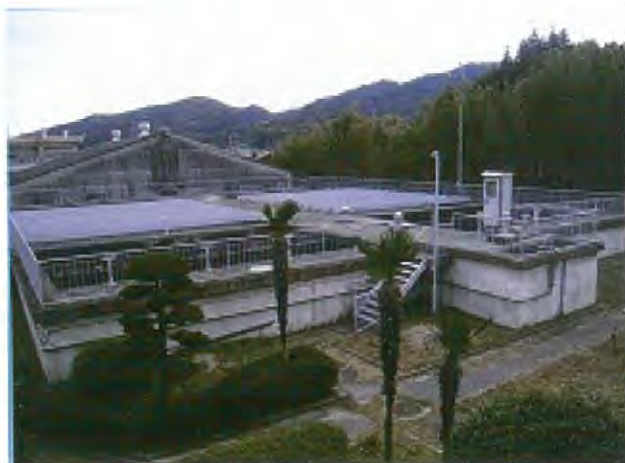
林浄水場沈殿池
